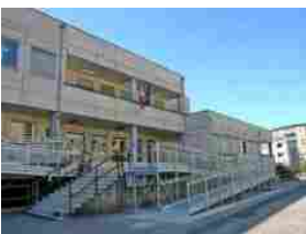
Riqualificazione scuole nella Provincia della Spezia
