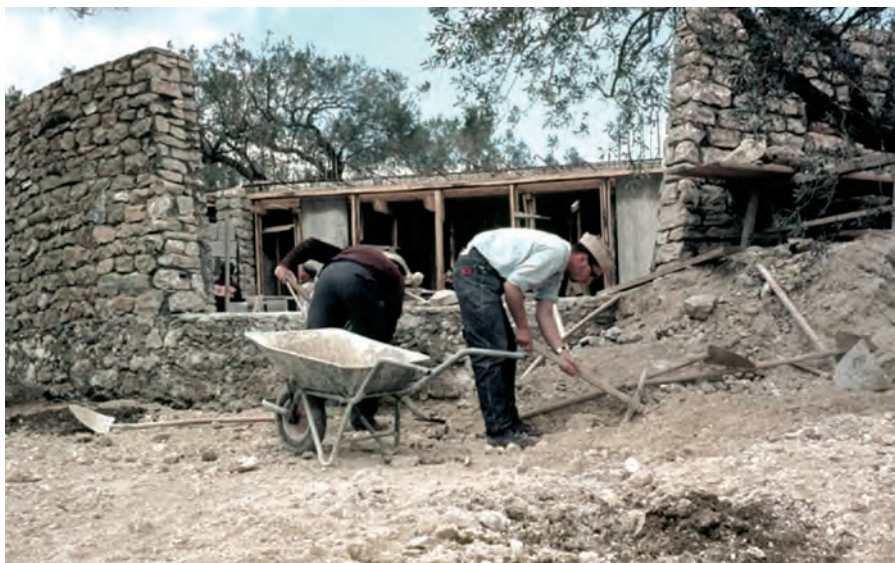
6. Operai al lavoro per la costruzione dell'Asilo (Archivio del Servizio Cristiano del Centro Valdese di Riesi).
