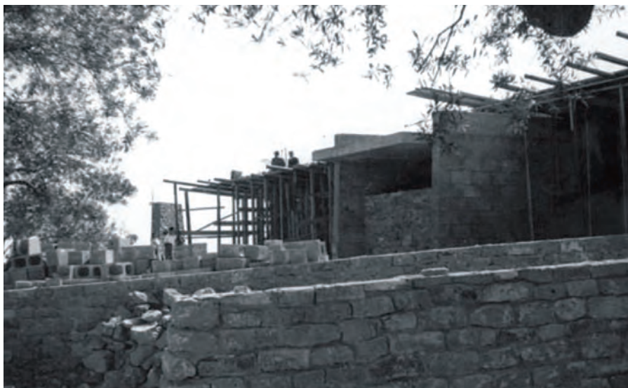
7. L'Asilo in Costruzione (Archivio del Servizio Cristiano del Centro Valdese di Riesi).
