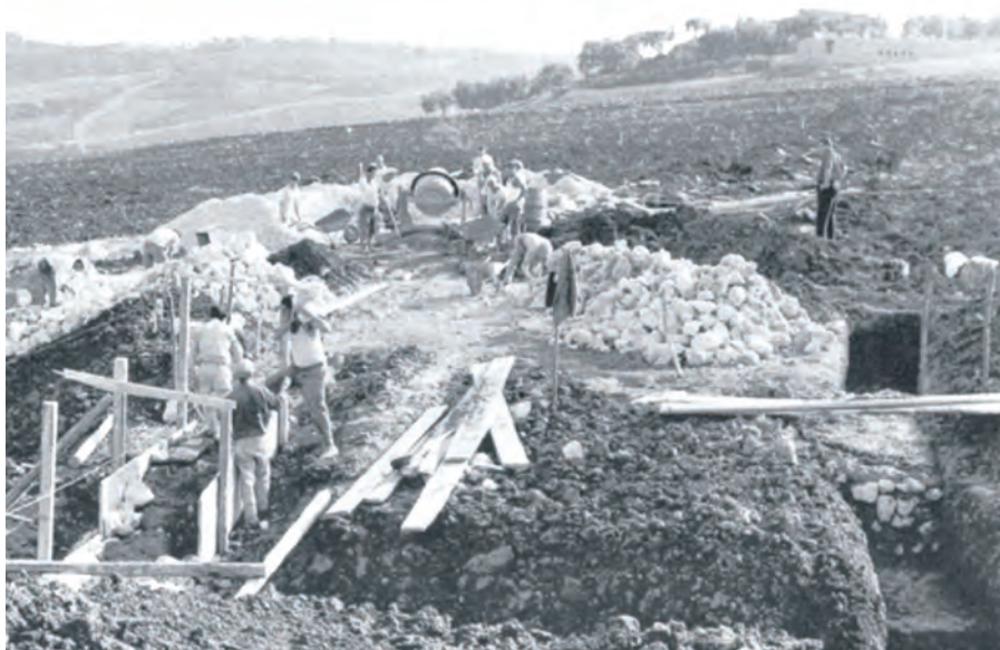
3. Il cantiere del Villaggio di Monte degli Ulivi (Archivio del Servizio Cristiano del Centro Valdese di Riesi).
